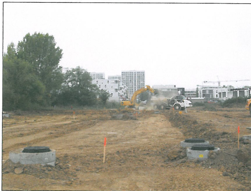
Figure n°1 : Piquetage des aires polluées.
